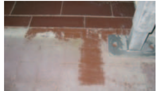
Abb. 1: Effektivste Reinigung mit Trockeneis – entfernt zuverlässig hartnäckigste Verschmutzungen
