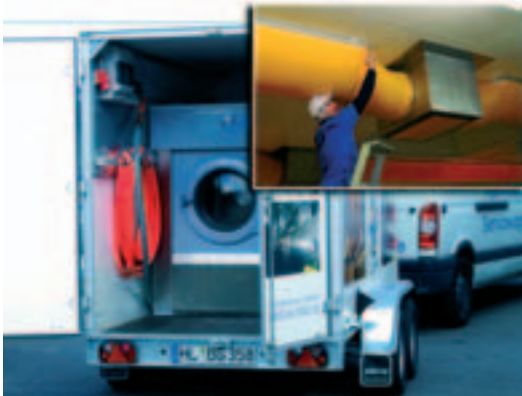
Abb. 3: Minimierung der Rüstzeiten und Kosten durch die mobile Luftsackreinigung vor Ort verbunden mit der Vermeidung einer Rekontamination
